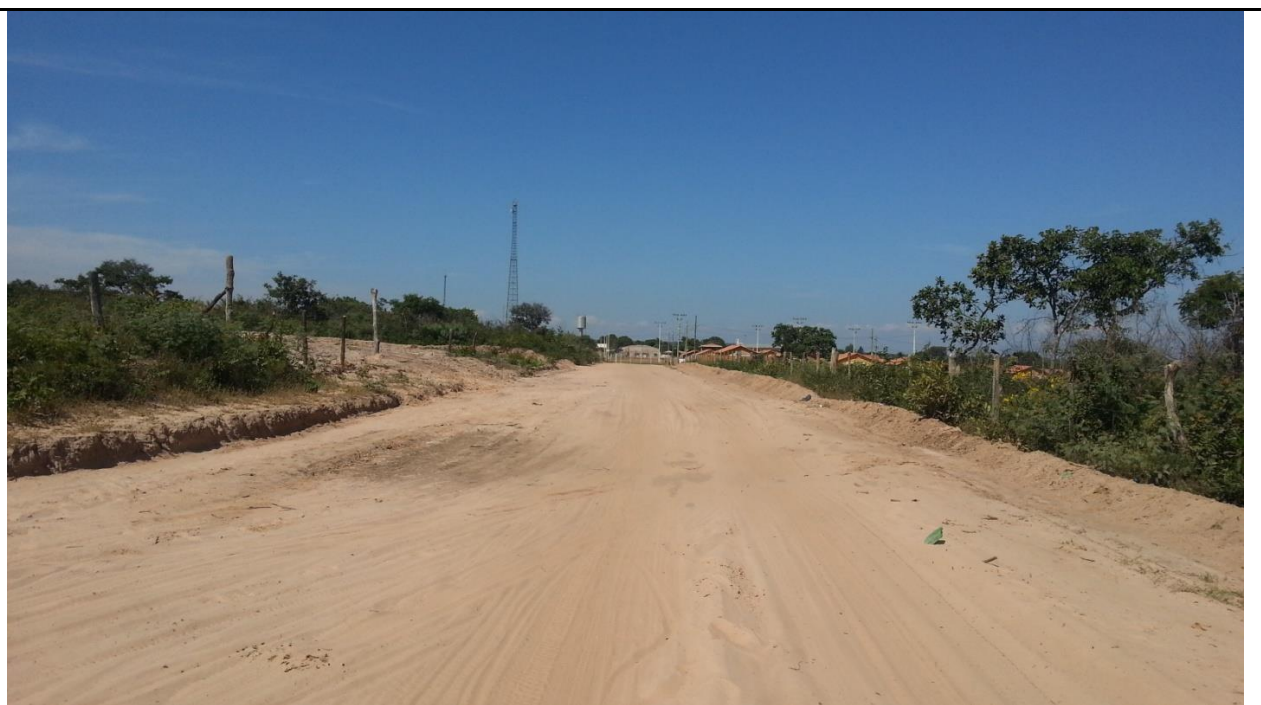
Foto 4: Tipo de obra: Pavimentação de Vias Públicas
