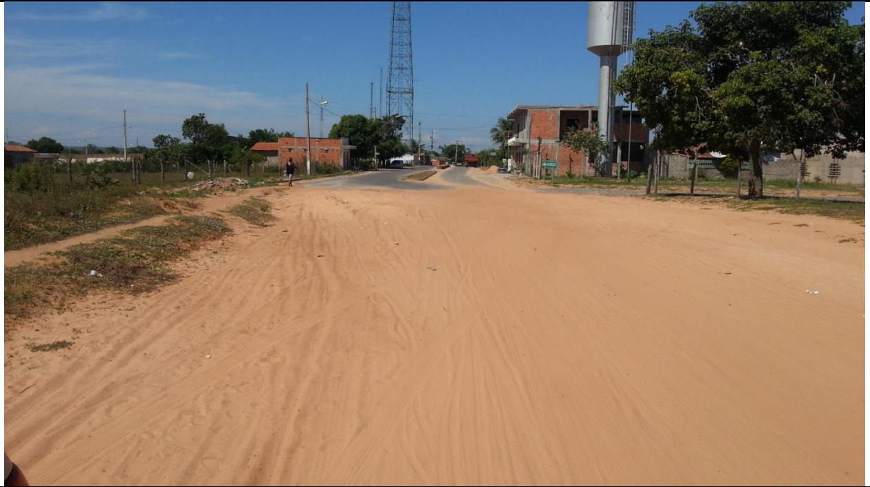
Foto 1: Tipo de obra: Pavimentação de Vias Públicas
