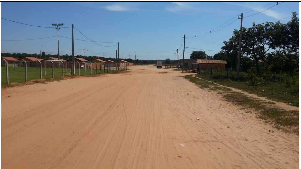
Foto 2: Tipo de obra: Pavimentação de Vias Públicas
