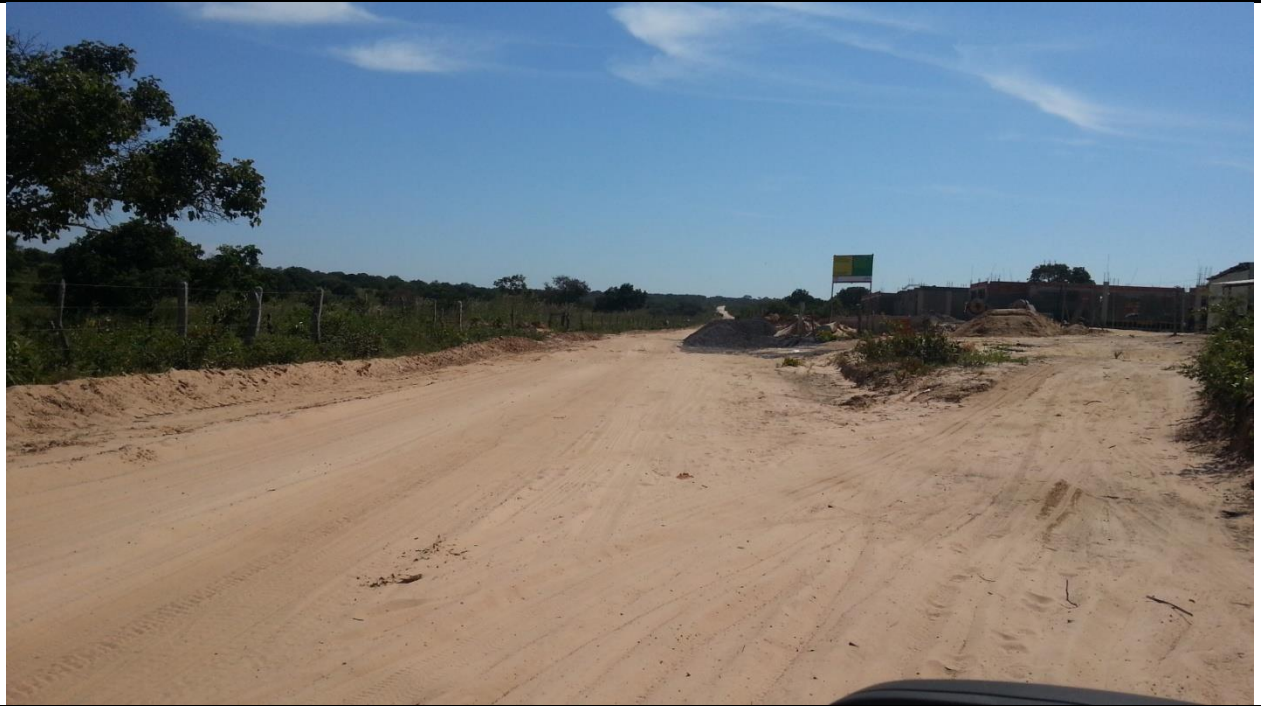
Foto 3: Tipo de obra: Pavimentação de Vias Públicas
